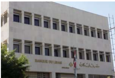
BANQUE DU LIBAN Waterproofing
