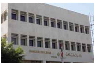
BANQUE DU LIBAN - BEIRUT Waterproofing
